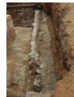
PIC01366 Mur u.e. 10018
