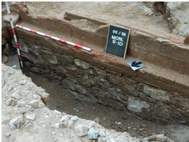
Vista del mur i la seva banqueta de fonamentació
