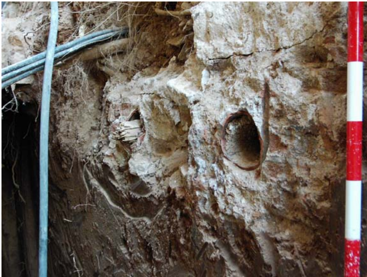
Vista de les canalitzacions ceràmiques dels col·lectors
