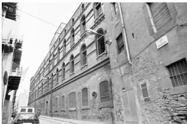
Imatges del procés d'enderroc de les dependències de la Casa de la Misericòrdia l'any 1993 (Fotos cedides per VECLUS,SL)
