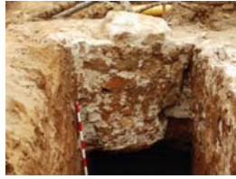
PIC00595 Detall mur 9006
