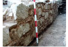
PIC00445 Detall parament mur u.e. 5012
