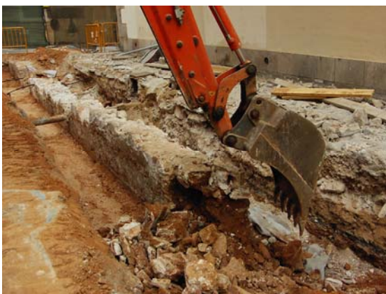
Vista de les tasques d'afectació parcial del mur. A la dreta un cop finalitzat el repicat
