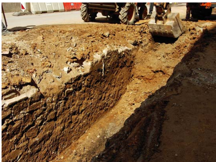
Vista del mur de tancament u.e. 8002
