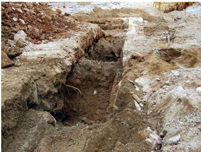
Vista des del Nord del procés d'excavació mecànica del Sector 8
