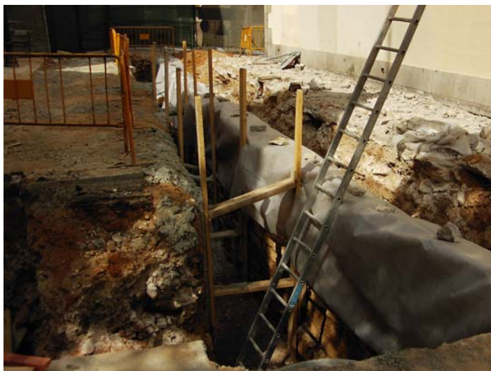
Vista del procés de cobriment dels elements amb geotèxtil
