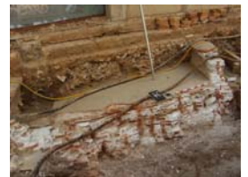
PIC01419 Desmuntatge safareig
