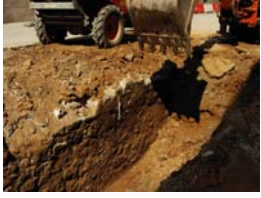
PIC01169 Mur u.e. 8002
