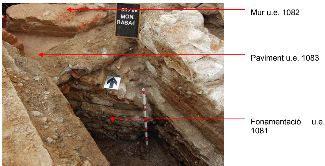
Vista en alçat de la fonamentació u.e. 1081, el mur de façana u.e. 1082 i el paviment u.e. 1083
