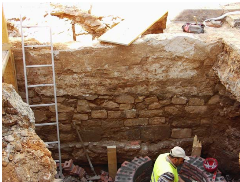
Vista dels murs abans de procedir a la seva eliminació mentre es construeix el pou d'escomesa dels serveis
