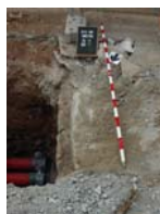
PIC02032 Mur u.e. 4061
