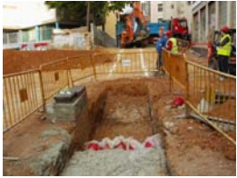
PIC01195 Vista del Sector a excavar
