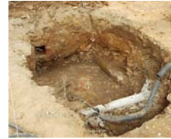
PIC01253 procés d'excavació
