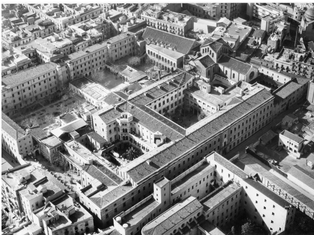
Aspecte del conjunt d'edificis que formaven la Casa de la Misericòrdia i la Casa de la Caritat abans de l'enderroc que es portar a terme l'any 1993 (foto cedida per VECLUS, SL)
