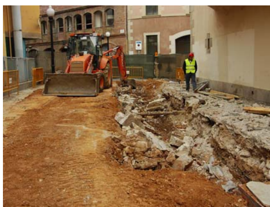
Vista de les tasques d'afectació parcial del mur. A la dreta un cop finalitzat el repicat
