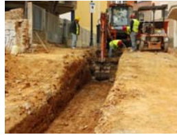
PIC01245 Excavació rasa
