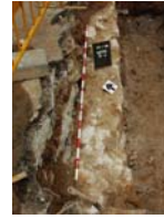
PIC01443 Mur u.e. 8195
